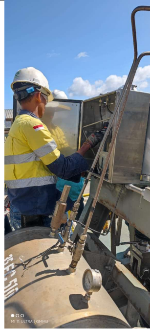
Pekerjaan Kalibrasi Valve
